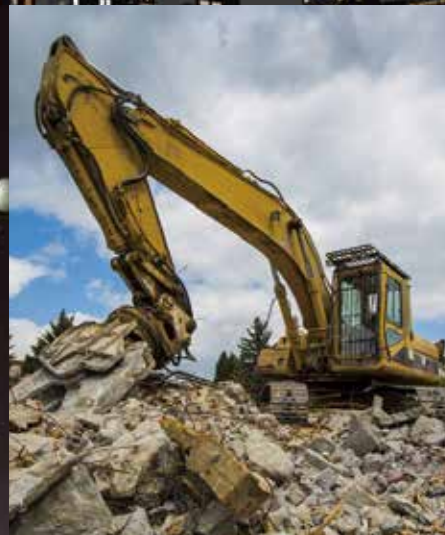
建機の遠隔操作
