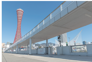
津波対策・防潮堤
