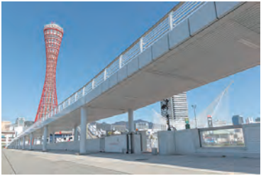
津波対策・防潮堤
