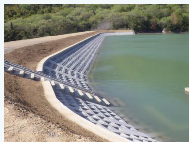
大谷池改修(姫路市)
